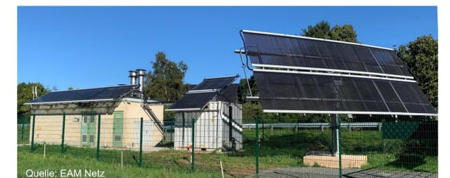
Drei Solaranlagenkonzepte: direkte Einspeisung, Drainback-Design & Nachführsystem
