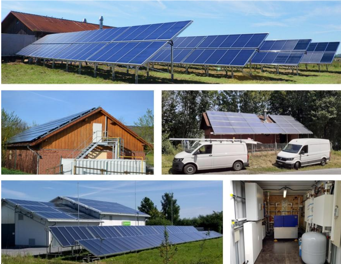
Abbildung 6: GDRMA Großseeheim (oben): 355 m 2 brutto solarthermische Anlage (STA) und Biogas-KWK-Abwärme; GDRMA Neu Eichenberg (Mitte links): 135 m 2 brutto STA und 3 GWP; GDRMA Ostheim (unten links): 420 m 2 brutto STA und 3 GWP; GDRMA Dillenburg (Mitte rechts und unten links): 58 m 2 brutto STA und 30 kW th BHKW.
